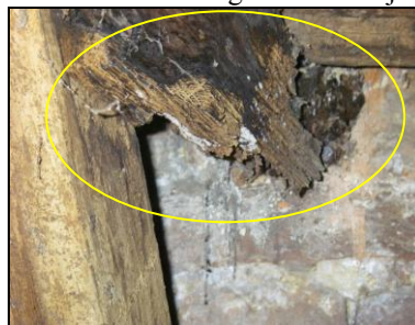
Foto: Doorgerotte draagstructuur van de zaling. [I 1-2g]
