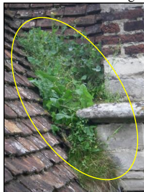
Foto: Verstopte kilgoot en zaling door ernstige vervuiling en plantengroei. [I 1-2e]
