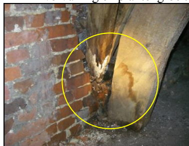
Foto: Ingerotte en vochtige structuren en onderliggend metselwerk door verstopte kilgoten.
