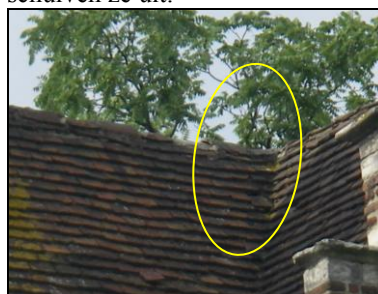
Foto: Uitgeschoven tegelpannen in de aansluiting met de kilgootbekleding. [I 1-2f]
