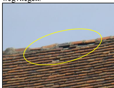
Foto: Uitgeschoven aanstrijkingen waardoor de nokstukken losliggen. [I 1-2c]
