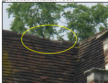
Foto: Gebroken en verdwenen nokstukken. [I 1-2d]
